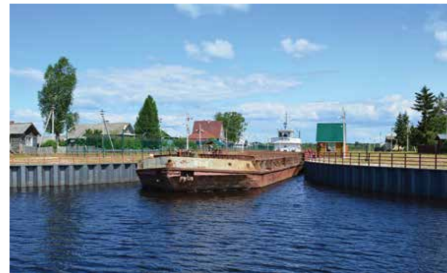
После проведенного капитального ремонта пропускать суда через шлюз № 7 – одно удовольствие!
