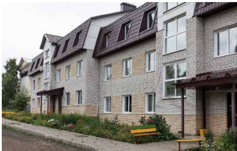
Белозерск. Дом на ул. Коммунистической. Такие дома долговечны, хорошо держат тепло и весьма экономичны.
