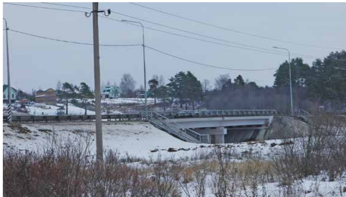
Ремонт моста через речку Ёму на трассе А-114 Вологда – Новая Ладога мостовики закончили еще в сентябре.
