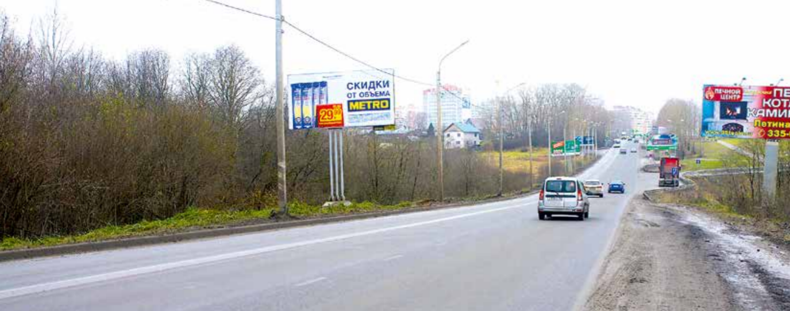
Ежедневно тысячи водителей теперь с удовольствием проезжают по участку Окружного шоссе в Вологде возле торгового комплекса «Лента». Этот отрезок дороги был недавно капитально отремонтирован компанией «Дорсервис».
