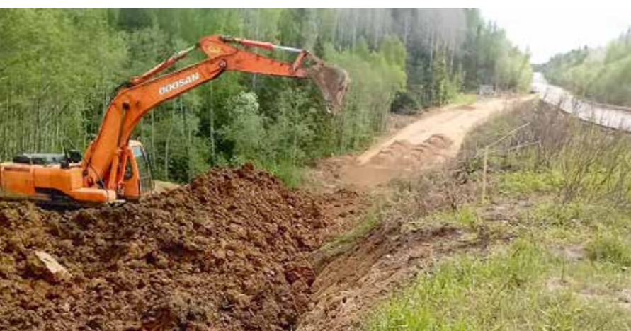
Строительство подъездов к временному мосту через Пельшму в Тотемском районе Вологодской области – не самый крупный, но тоже важный объект этого года.
