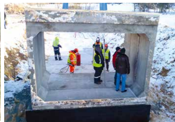
Такую гигантскую трубу дорстроевцы монтировали на съезде транспортной развязки строящейся окружной автодороги вокруг областной столицы.
