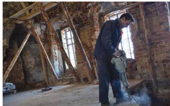
Работы в восстанавливаемой церкви предостоят много. Например, пол за два столетия стал похож на слоеный пирог, его уровень приходится понижать больше чем на метр.
