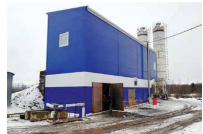
Новый цементно-бетонный завод компании «Автодороги Вытегра» производит качественный цементобетон, соответствующий современным стандартам.
